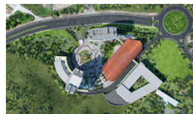
Masterplan ↑ Vue d'ensemble du projet comprenant l'hôtel Hilton et le Centre des congrès Kutubu.
